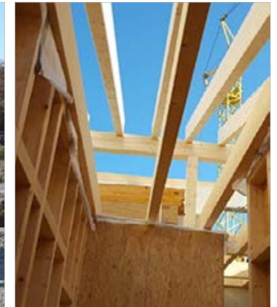
Vibratec Baustelle II | Foto: Michael Borger
