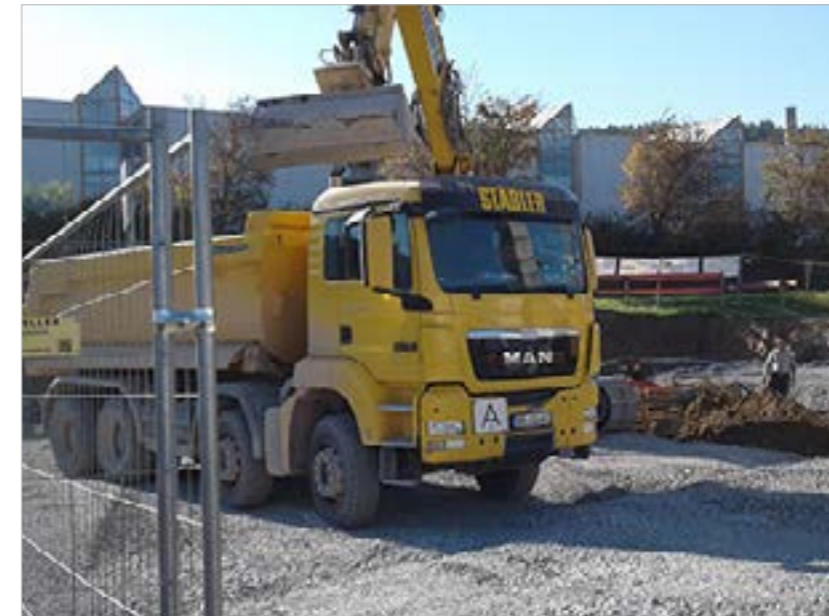
Vibratec Baustelle I. | Foto: Michael Borger
